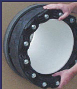
3. Faites glisser l'assemblage Innerlynx® dans l'espace annulaire. La lubrification avec une solution mince de savon / eau peut aider si elle est serrée.
