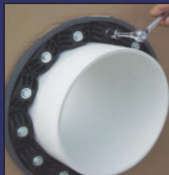
6. Commencez par le boulon situé à 12 heures avec 2-3 tours de clé / rochet. Continuez dans le sens des aiguilles d'une montre. Ne serrez pas en étoile.
